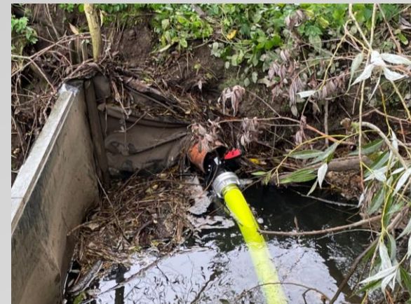
27.10.2023 – Wasserschlauch der FFW Calden hilft beim Durchspülen des Zulaufes
