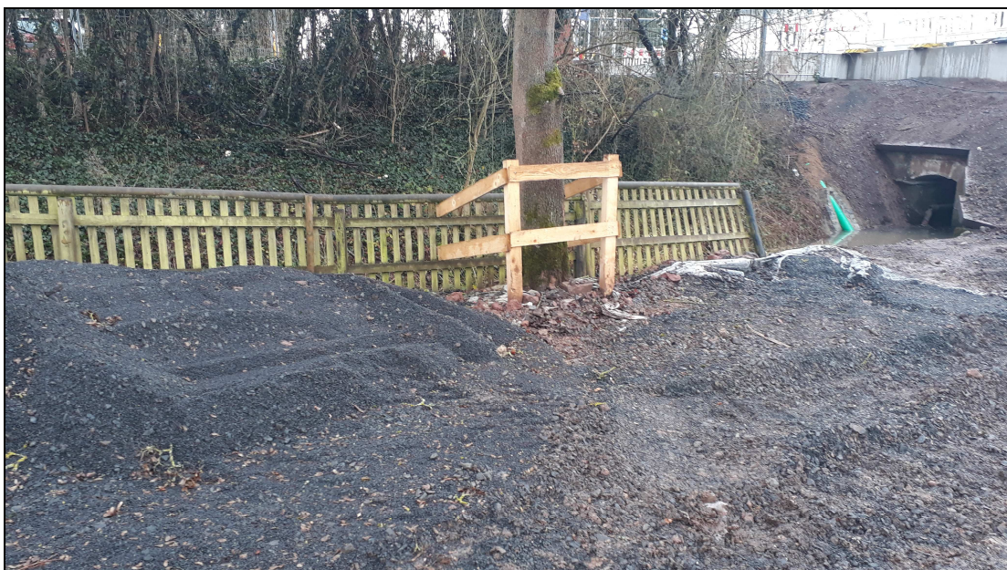
Seitlich vorhandene Grabenmulde mit Zaunsicherung und Rahmendurchlass durch Bahngelände „rechts“
