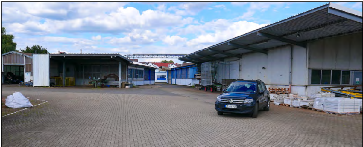
Abbildung 2: Neuere Hallen des Gewerbe-Ensembles von der Bahnseite im Westen
