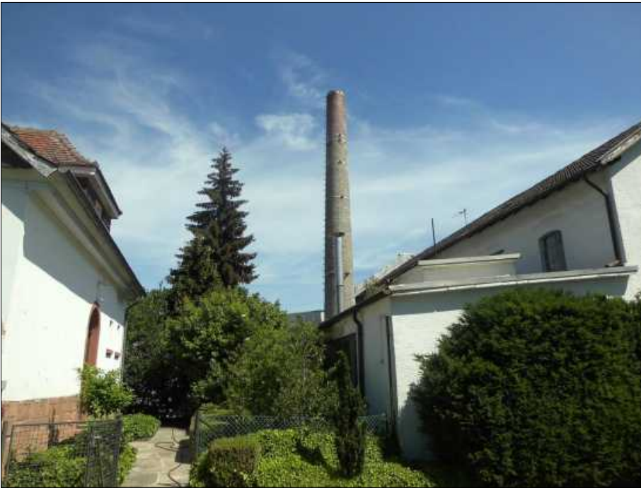
Foto 4: Der Industrieschornstein (frühere Werksheizanlage?) gehört neben den Seitengebäuden zum Abbruchvorhaben im VG1. Blickrichtung vom Rasenplatz nach Nord. 03.06.2022-HGF
