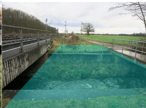
Links Foto 7, mit Blick in Richtung Süden. Derzeitiger Steg mit einer Breite von 1,50 Meter über den Hegbach. (Foto aufgenommen am 19.01.2018). Rechts Foto 8: Fotomontage vom zukünftigen Steg für die Radfahrer mit einer Breite von 4 Metern mit Blick in Richtung Norden. (Foto aufgenommen am 02.01.2018).
