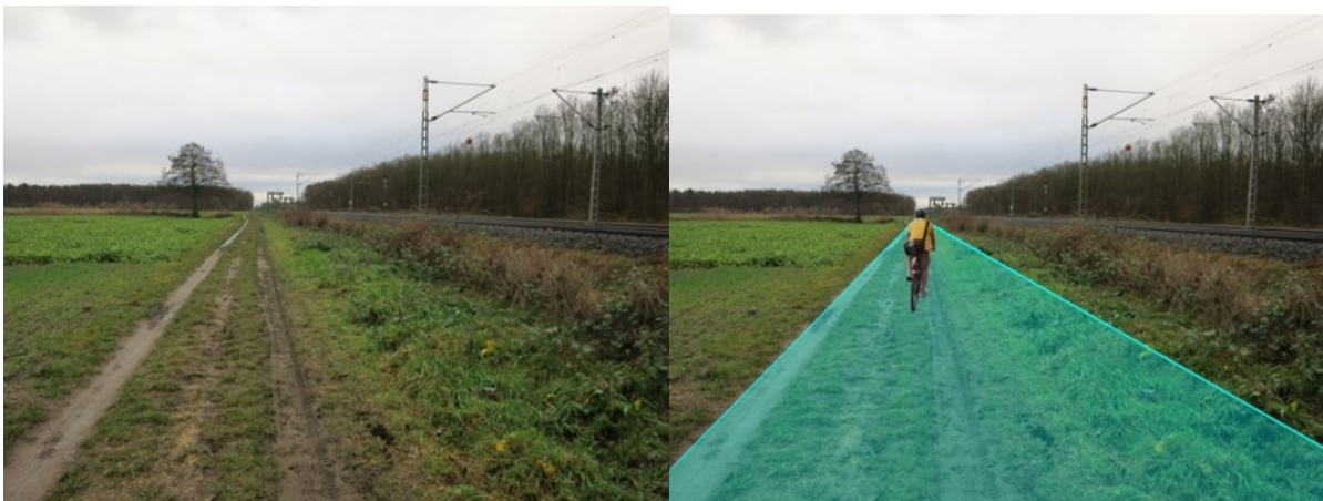
Links Foto 2: Vorhandener bewachsener Feldweg mit einer Breite von circa 3 Metern. Rechts Foto 3: Die Fotomontage zeigt auf, wie der zukünftige Radweg mit einer Breite von 4 Meter verläuft (Fotos aufgenommen am 19.01.2018).
