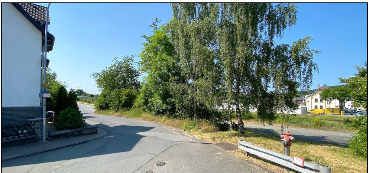
Abbildung 5: Infrastruktursituation im Westen des Plangebiets, Blick nach Westen (06/2023)
