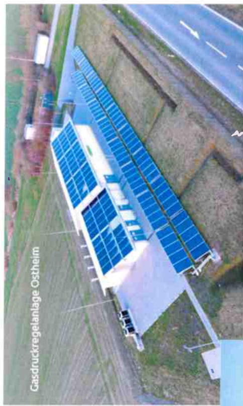
Solarthermische Gasdruckregelanlagen
