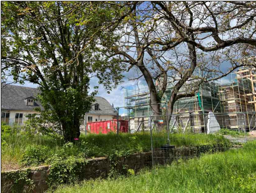
Abb. 1: Blick von Südosten von der Schwalbacher Straße aus.
