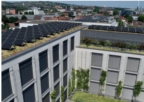
Abb. 8: Zukunftstr chtige Kombination Klimaschutz und Klimawandelanpassung: Solar-Gr nd cher. Quelle: BuGG
