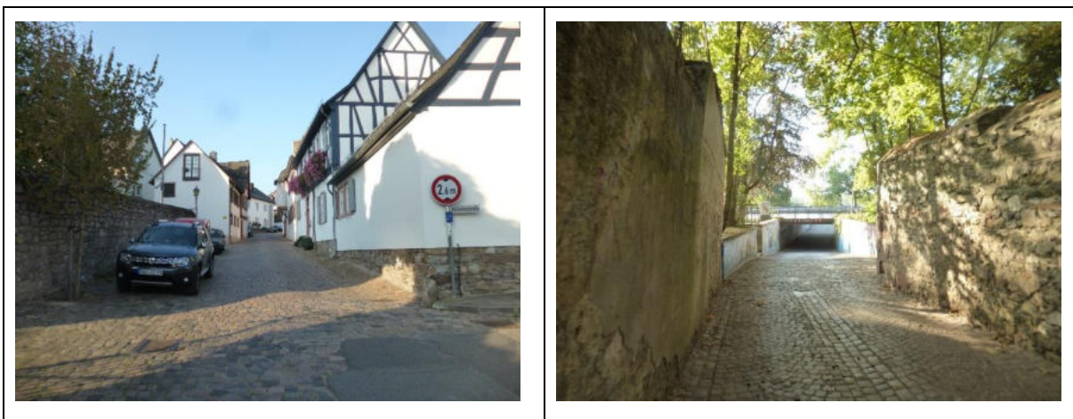
Bild 3-14: Burggraben und Unterführung Pfarrgasse in Hattenheim
