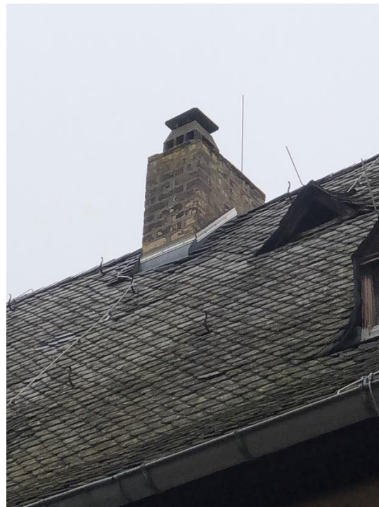
Kamin vorgesehener Abriss bis unter Dach
