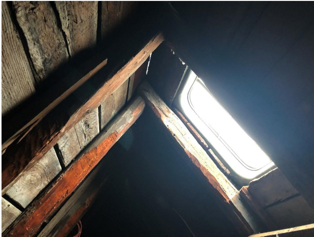
Spitzboden Dachflächenfenster Westseite
