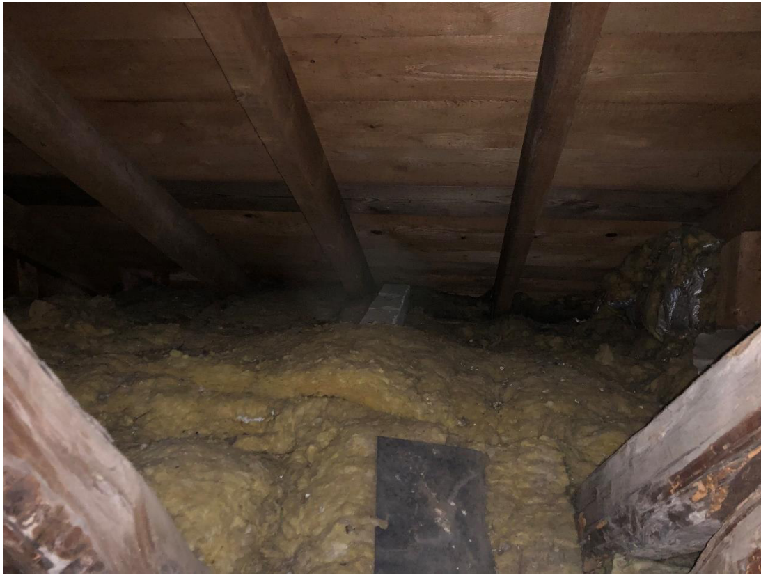
Dämmung auf Schleppgaube
