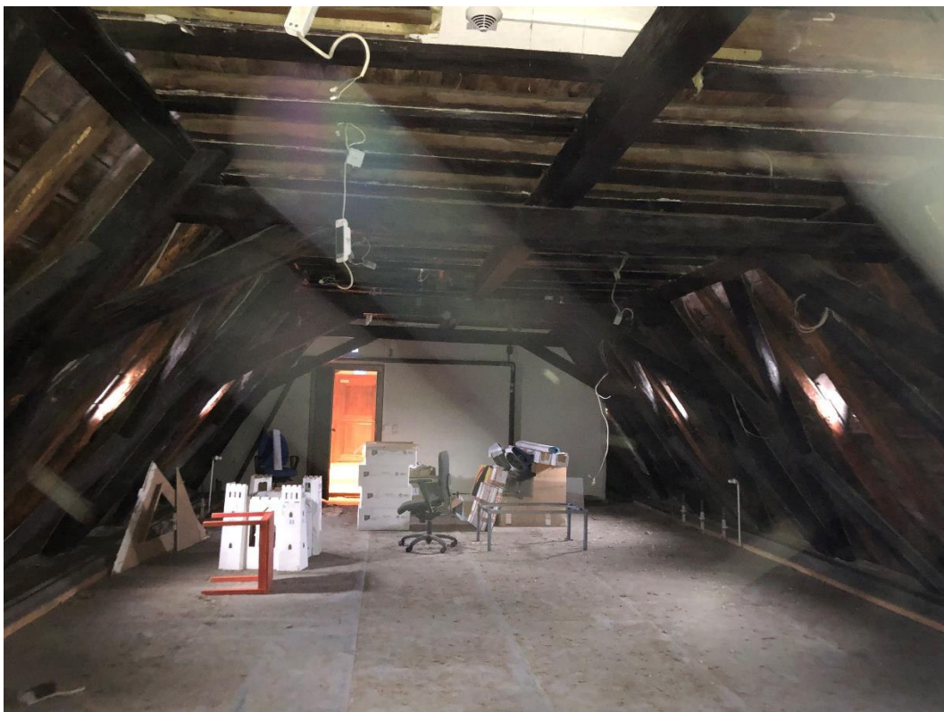
Dachinnenraum Blickrichtung Nord (WC- Anlage)
