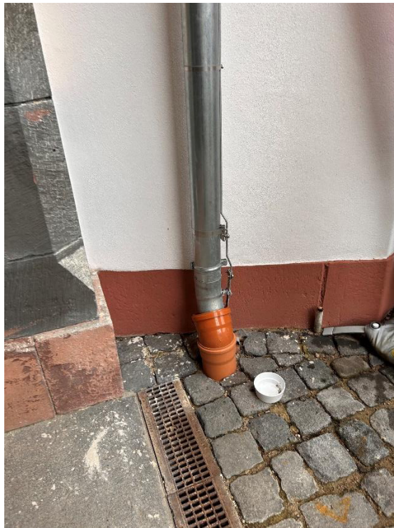
Fallrohranschluss Westseite
