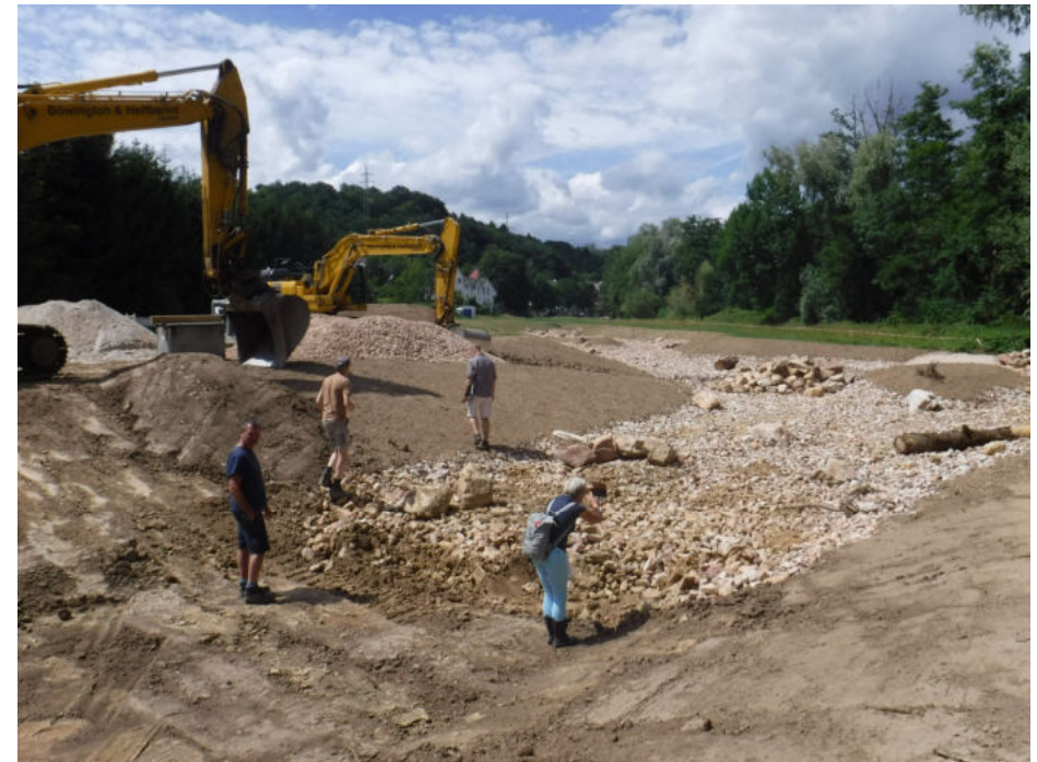
Beispiel Wallufrenaturierung: Ausbau der Furt im Bachbett (Befahrung der Insel), Quelle Abb. & Foto: Planergruppe ASL, Frankfurt a.M.
