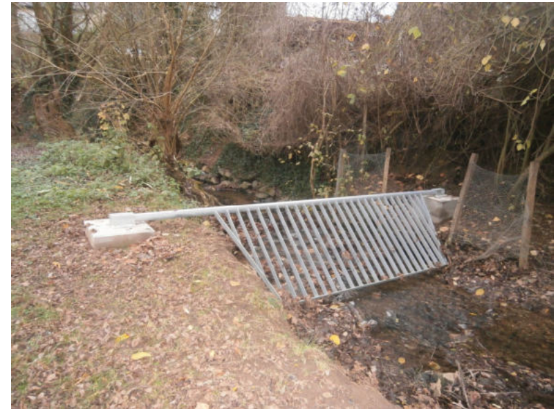
Bachhöll, Erbach 2015: Schutz vor Einlauf in die Verrohrung durch Einbau zusätzlicher Grobrechen, um bei Starkregen Angeschwemmtes aufzuhalten und in das Überschwemmungsgebiet abzuleiten
