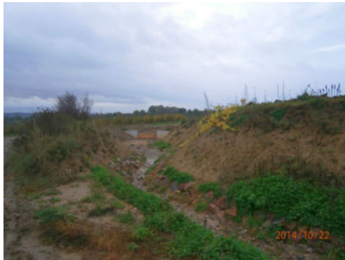
Beispiele AfB Abnahmen: Martinstal 2014
