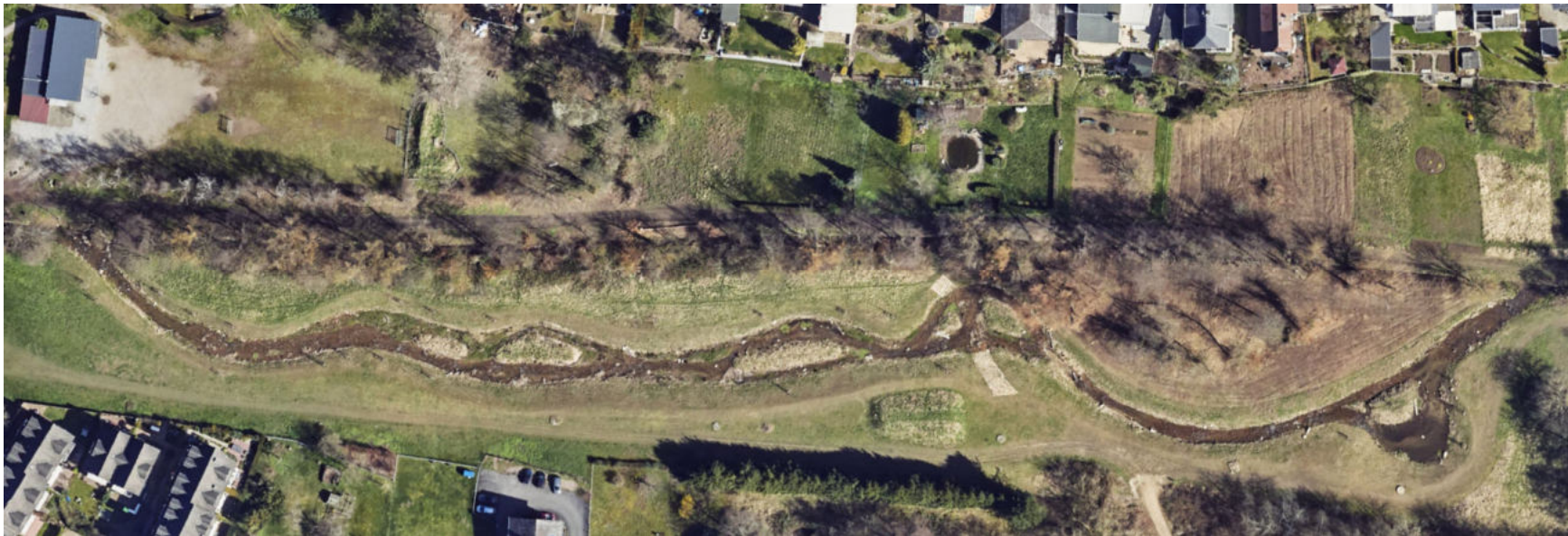
Beispiel Wallufrenaturierung: Luftbild 2022, Quelle: Stadt Eltville, Geoinformationssystem CAIGOS
