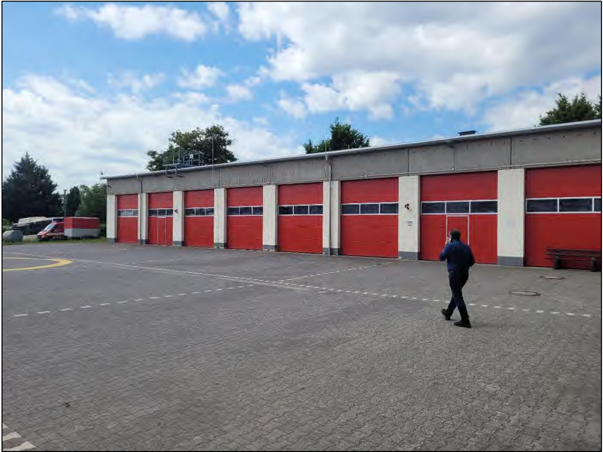
Abbildung 4.4 Feuerwehrhaus Eltville am Rhein
