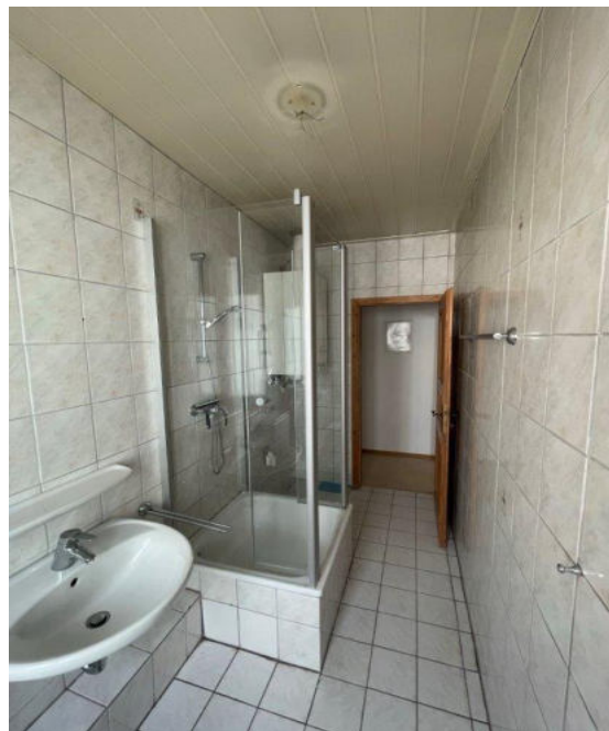
Alte abgeh. Decke aus KS-Elementen
