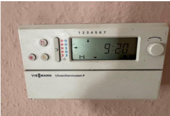
Vorh. Viessmann Therme im Bad und Steuerung im Zimmer 3
