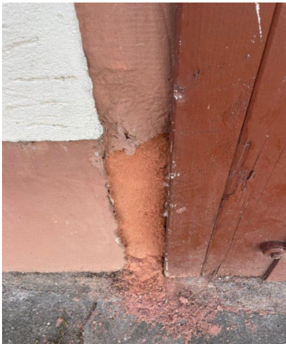
Sandsteinschäden und Türbeschläge verrostet
