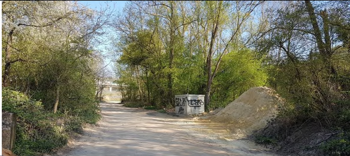
Foto 8: Trafostation östlich des Wirtschaftswege
