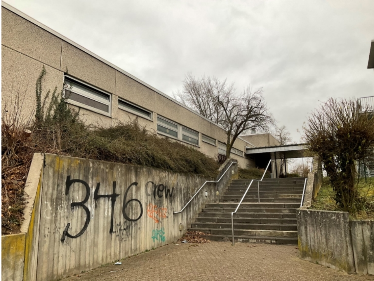
Ansicht von der Haupteingangsseite
