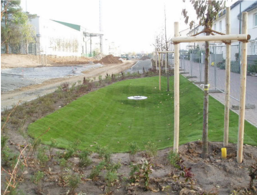
Abbildung 11: Beispiel eines Mulden-Rigolen-Elementes mit Überlauf (eigene Darstellung)
