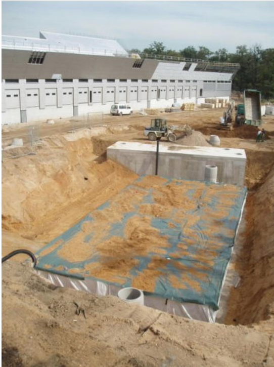
Abbildung 8: Einbau einer Versickerungsrigole (eigene Darstellung)
