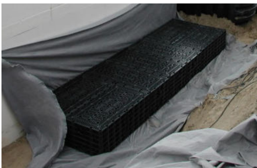
Abbildung 9: Rigole aus Kunststoffelementen (eigene Darstellung)
