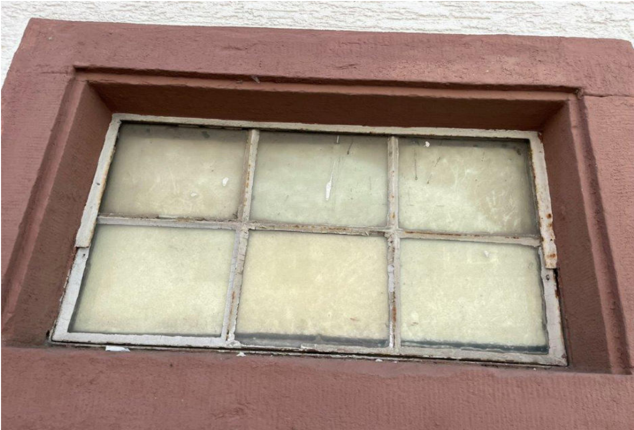
Fenster EG, maroder Glaskitt und verrostete Rahmeneinfassungen
