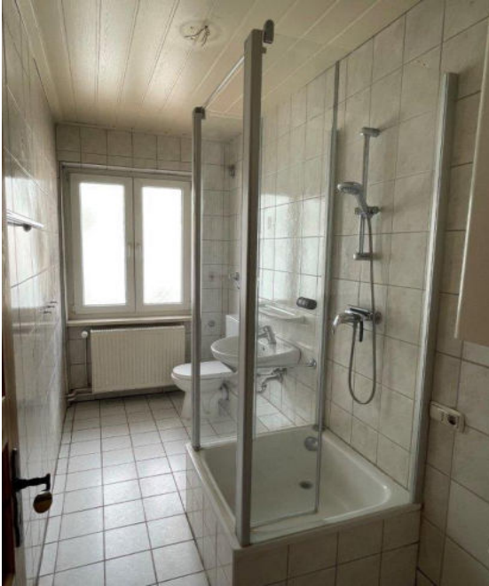
Bad raumhoch gefliest mit alten Sanitärobjekten
