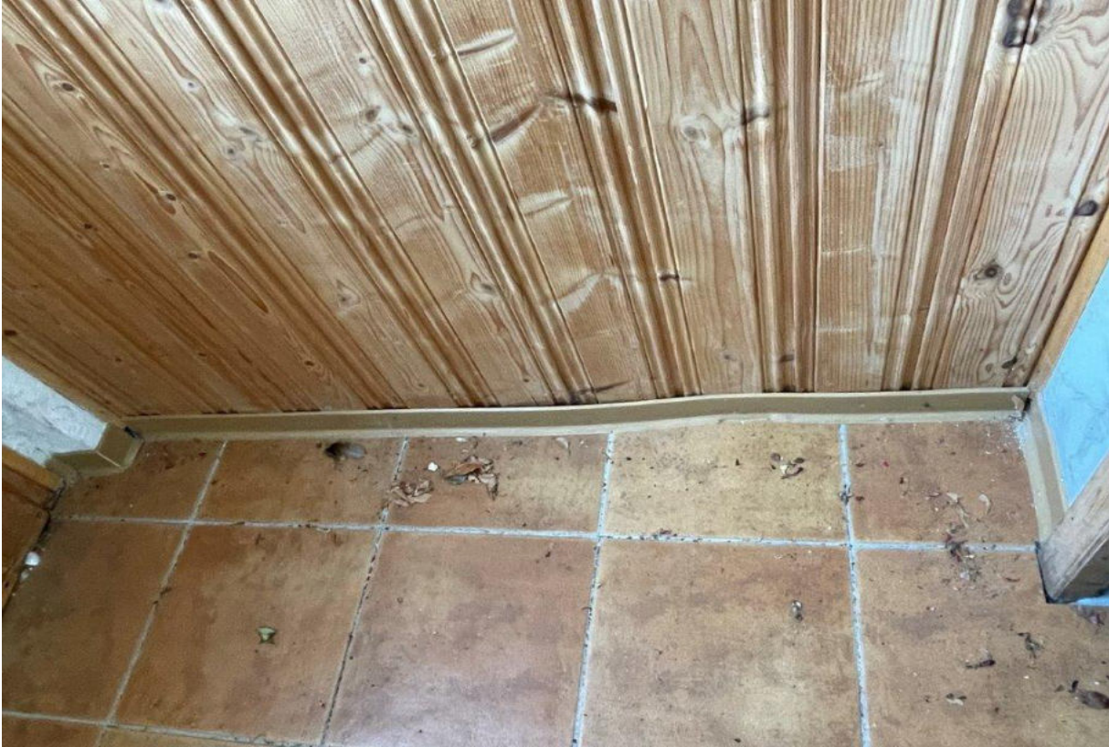
Verkleidung Wand Eingangsbereich EG, alte KS-Fußleisten
