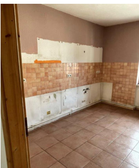
Küche- Bodenbelag (gestückelt)
