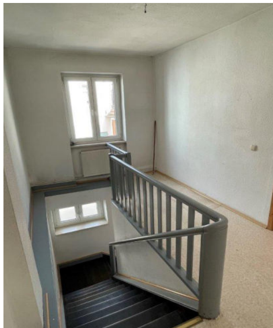
Holz - Treppe mit Geländer
