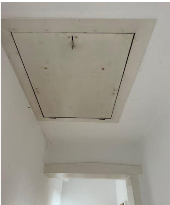
Dachluke und Rahmen Flurdurchgang
