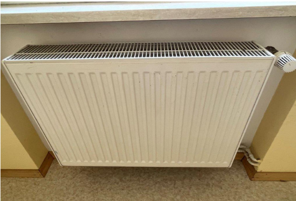
vorh. Heizkörper und Thermostatventile und Leitungen (größtenteils auf Putz)
