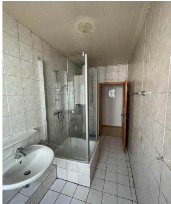
Alte abgeh. Decke aus KS-Elementen
