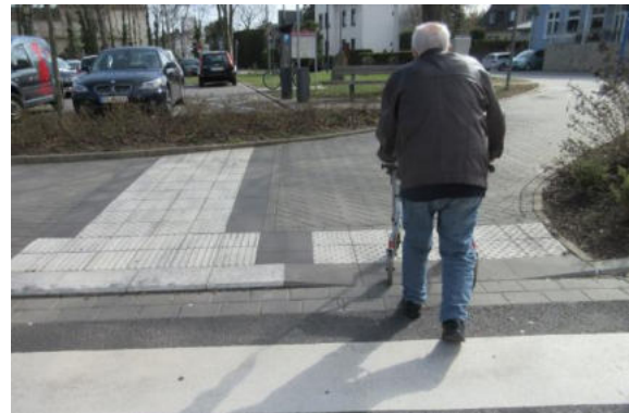
Zielkonflikt der Nutzergruppen mit der Bordhöhe, dazu der Lösungsansatz mit Doppelbord
