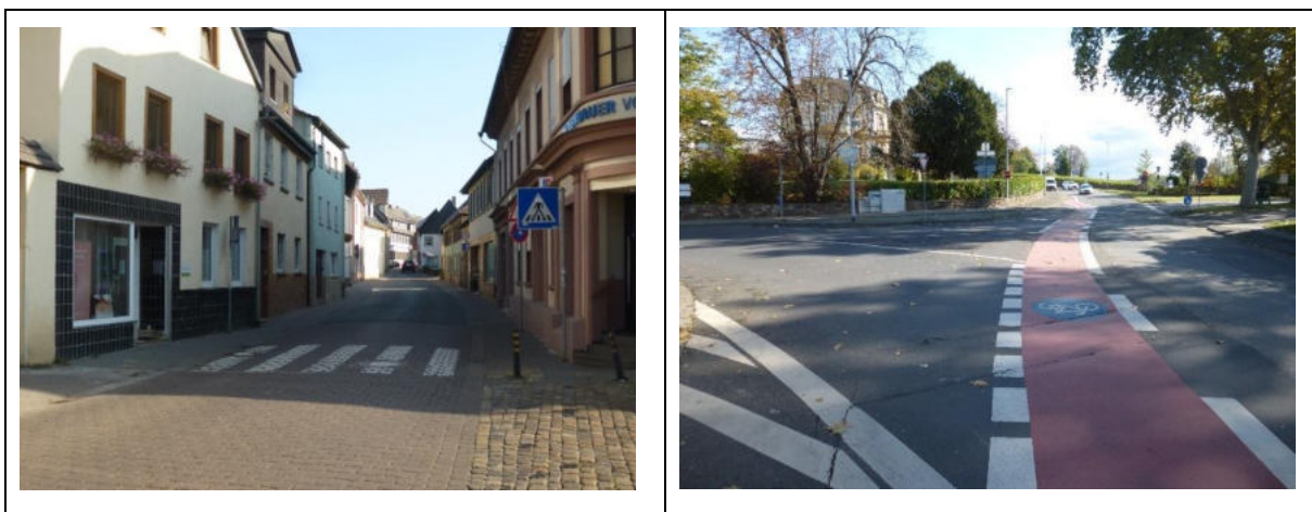
Bild 3-12: gesicherte (FGÜ) und ungesicherte Querungsstellen (Gutenbergplatz)
