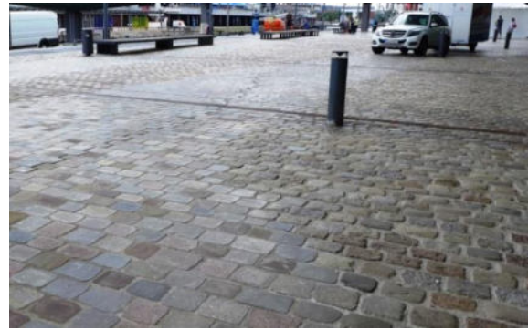
Bessere Begeh- und Berollbarkeit durch abgeschliffenes bzw. geschnittenes Pflaster
