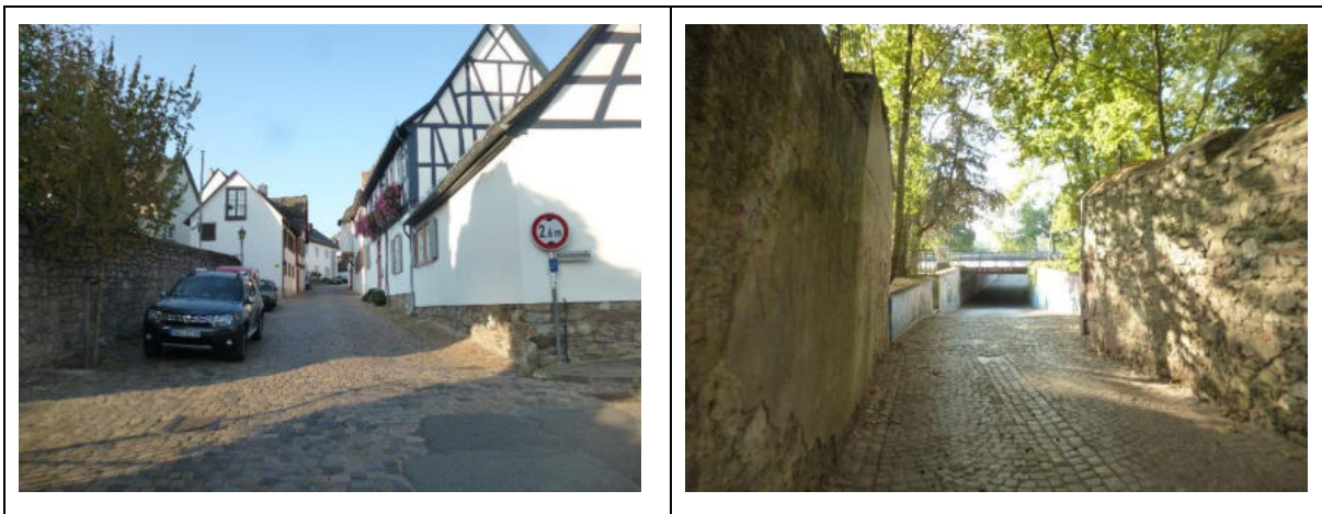
Bild 3-14: Burggraben und Unterführung Pfarrgasse in Hattenheim
