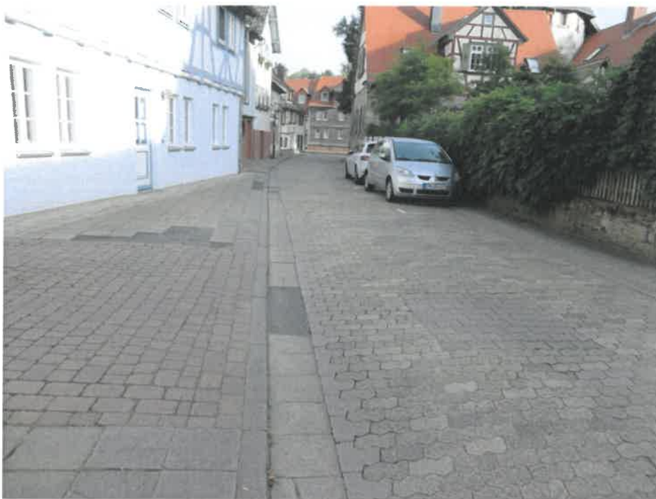
Abbildung 20: Uneinheitlicher Pflasterbeleg und Anwohnerparken im Schloßgraben Quelle: Eigene Aufnahme.
