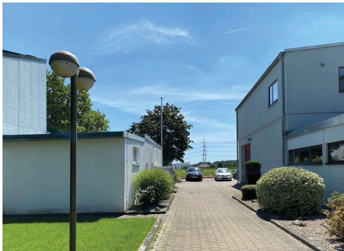
Blick zwischen Bürgerhaus (l.) und Feuerwehr (r.)
