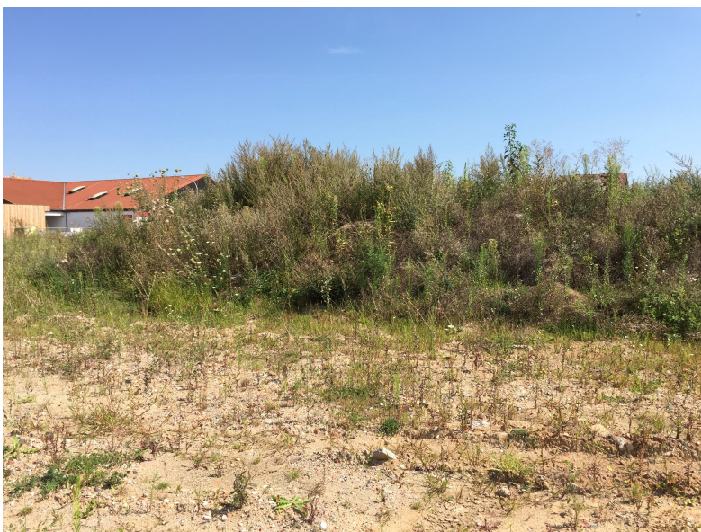
stark bewachsenes Hauwerk
