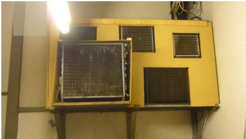
Verflüssiger-Einheit in Außenwand / Lichtschacht – Wärmeabgabe an den Raum
