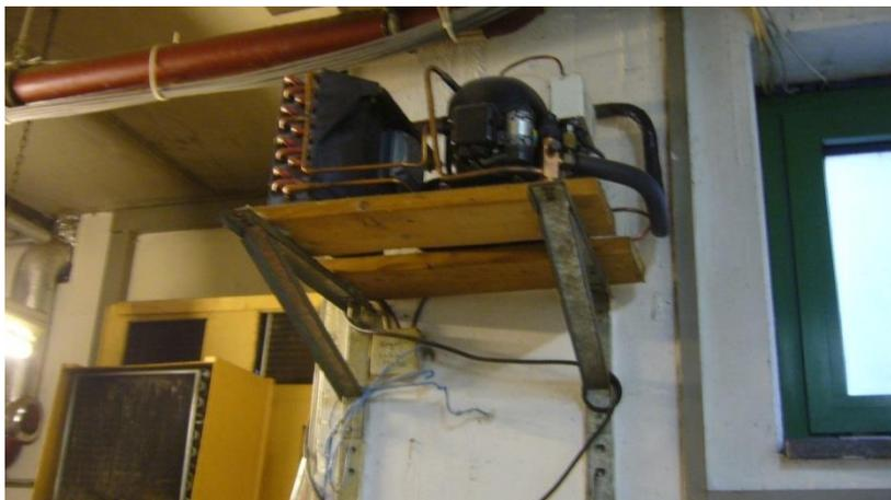
Verflüssiger-Einheit Kegelbahn - Wärmeabgabe an den Raum
