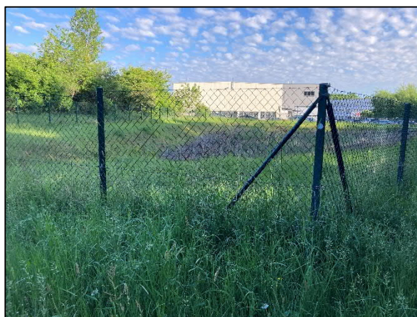
Abb. 20: Regenrückhaltebecken mit Umzäunung (eigene Aufnahme 05/2025).
