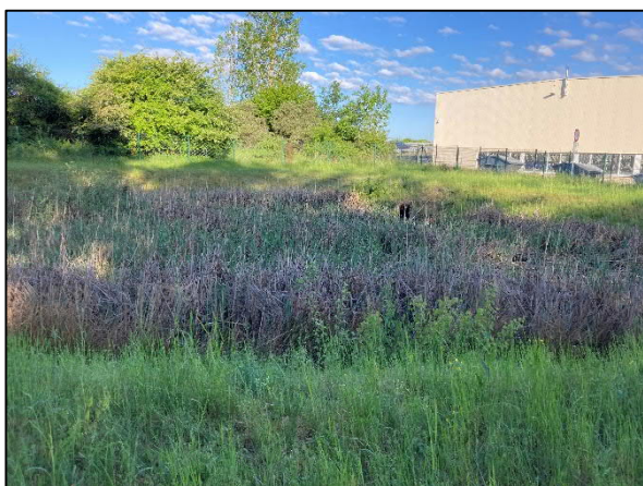
Abb. 19: Blick auf das Regenrückhaltebecken (eigene Aufnahme 05/2025).
