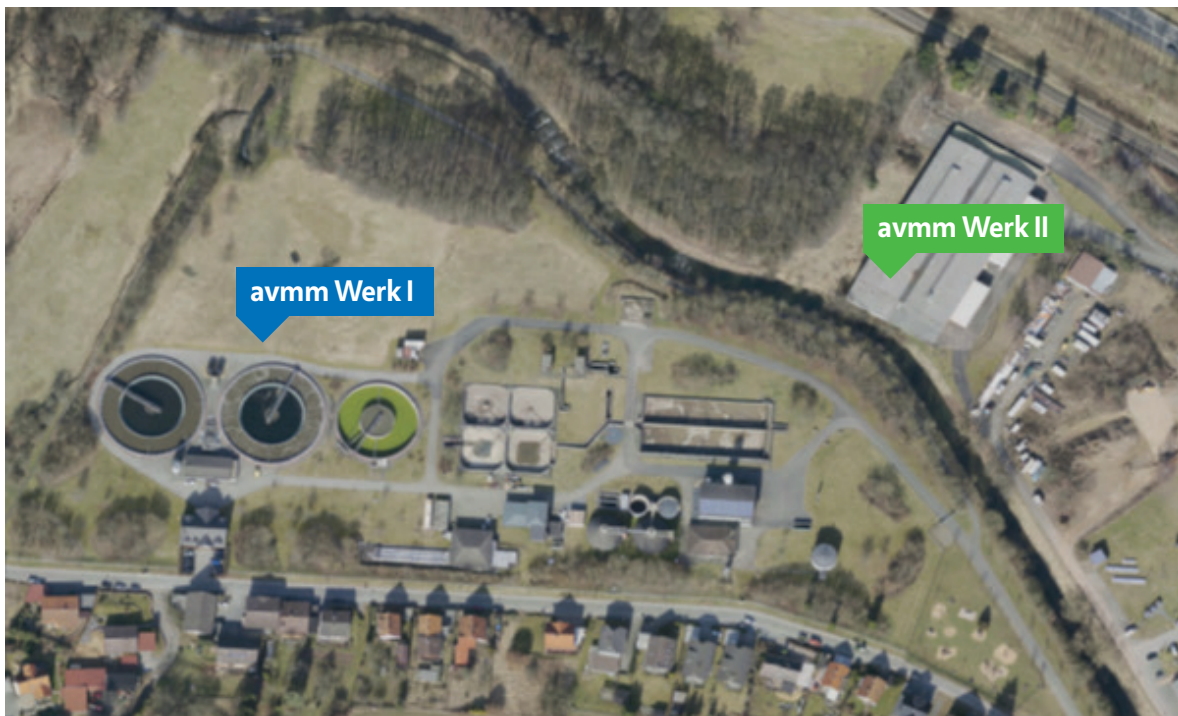
Abbildung 2: Luftbild Kläranlagengelände KA Asselbrunn Michelstadt und potentieller Standort für InterPhOs
