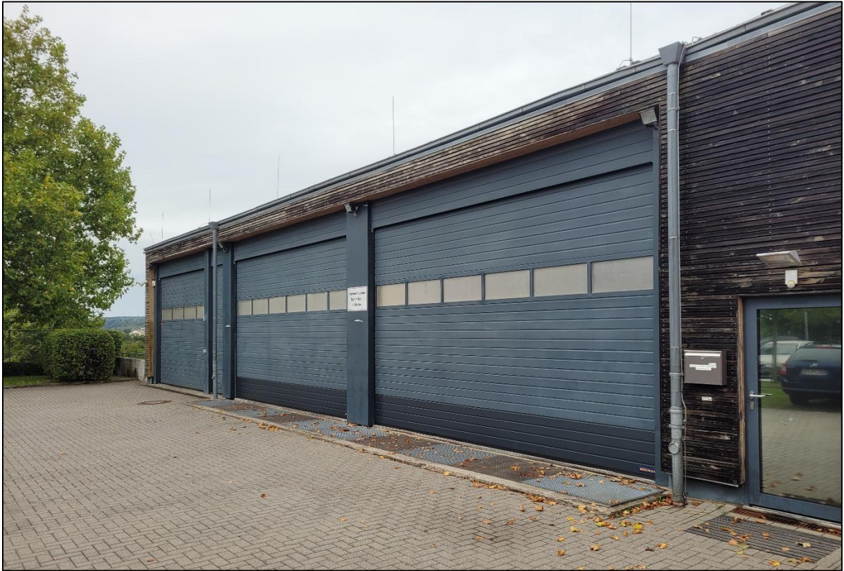
Abbildung 4.6 Foto Feuerwehrhaus Johannisberg
