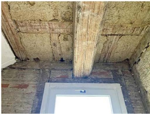
Die Auflagersituationen sind zu überprüfen, insbesondere für die beiden giebelparallelen Innenwände, wo der Unterzug auf einem Holzsturz, der mittels beidseitigem und bestenfalls 1,5 cm tiefen Versatz in die Leibungspfosten eingebunden ist.
