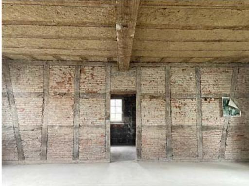
Die Deckenbalken über dem OG spannen giebelparallel (Gebäudequerrichtung) und lagern auf einem Mittelunterzug aus Holz auf. In der Mitte des ehemaligen Klassenraums ist der Unterzug mittels Rundstahl am Gebinde im DG hochgehängt (siehe Seite 1, oberes Foto).
