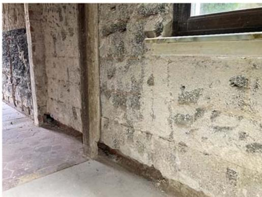
Am Wandfuß weist das Mauerwerk linienförmig Fehlstellen auf. Hier sind die Fehlstellen auszubessern.
