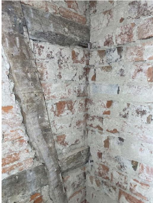
Die linke Bildhälfte zeigt die straßenseitige Fachwerkaußenwand, die rechte Bildhälfte das Mauerwerk, welches anstelle der Fachwerkwand errichtet wurde. Das Mauerwerk der Gefache scheint mit dem Mauerwerk der Außenwand augenscheinlich verzahnt vermauert zu sein.
