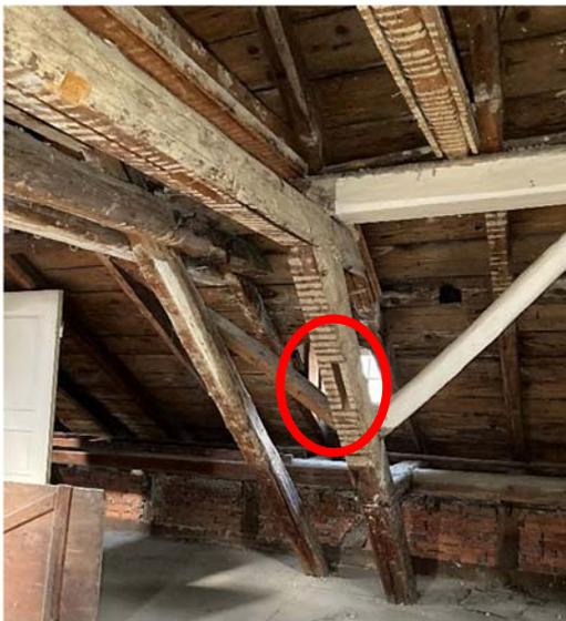
Bei dem mittleren Gebäude des liegenden Stuhls wurden die Kopfbänder entfernt-
