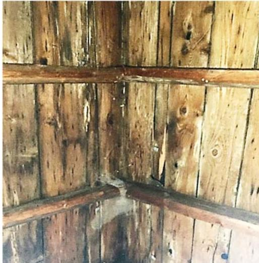
Die Schalung weist teilweise Wasserflecken auf. Die Sparren kragen über die Mittelpfette aus und sind am Firstpunkt mittels Blatt und Holznagel gelenkig verbunden. Die Sparrenquerschnitte sind im oberen Abschnitt (von Mittelpfette bis First) für einen Ausbau unterdimensioniert. Aufgrund der Wasserflecken auf der Unterseite der Schalung ist nicht auszuschließen, dass die Sparren auf ihrer Oberseite durch Feuchte geschädigt sind.
