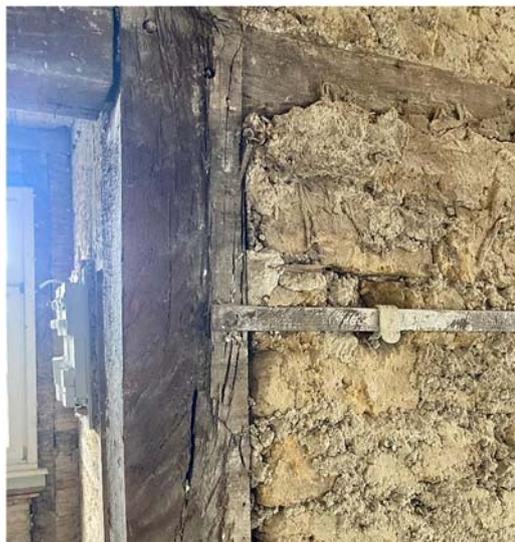
Unterhalb des Türsturzes verläuft ein horizontaler Flachstahl bis zur straßenseitigen Außenwand. Es ist noch detailliert zu prüfen, ob dieses aus statischer Sicht zu erhalten ist. Ggf. sind die Verbindungen der Riegel mit den Pfosten auf Kraftschlüssigkeit zu prüfen
