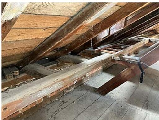
Die beiden Drempele der Traufseiten sind mittels Leiterbalken ausgesteift. Die Stichbalken sind in die Sparren eingezapft und mit Holznägeln gesichert.
