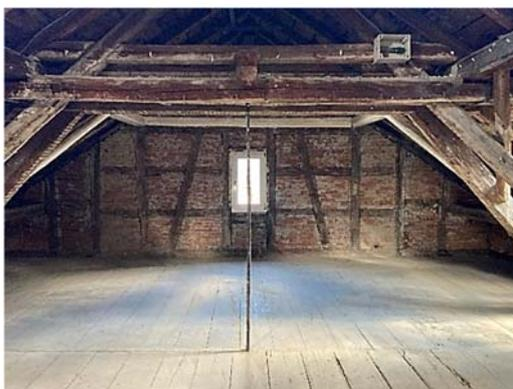
Es handelt sich um ein Pfettendach mit liegenden Stühlen. Der traufparallele Unterzug der Decke über dem OG ist über ein separates Stuhlgebilde mittels Rundstahl „hochgehängt“.
