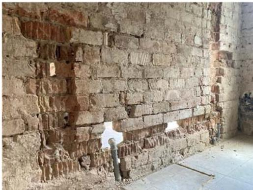
Die traufparallele Innenwand des Anbaus ist durch die vorgenommenen Installationen erheblich geschwächt. Da diese Innenwand als Mittelaufleger für die darüber verlaufende Balkenlage dient, muss diese rückgebaut und durch eine neue, tragfähige Innenwand ersetzt werden.
