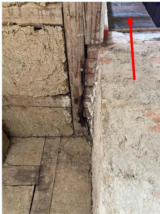
Auf der gegenüberliegenden Seite ist dieses Randholz im Bereich des Kamins (Pfeil) ausgeklinkt. Außerdem lagert das Randholz im Lehmgefach der Fachwerkwand auf. Als Verstärkung kann bspw. unterhalb der Balkenlage ein Randholz ergänzt werden und ist in der weiteren Planung zu konkretisieren.
