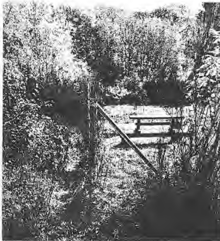
Gut erkennbar: Neuer Zaun
