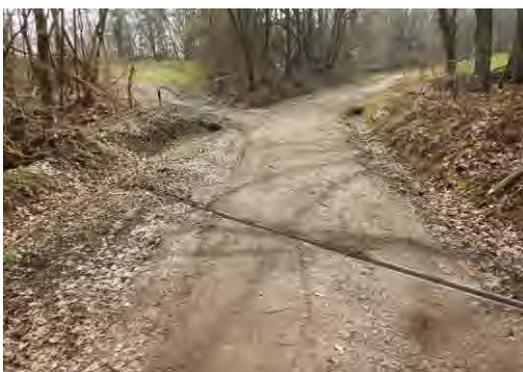
Abbildung 6: Wassergebundene Forstwegedecke mit Entwässerungsrinne
