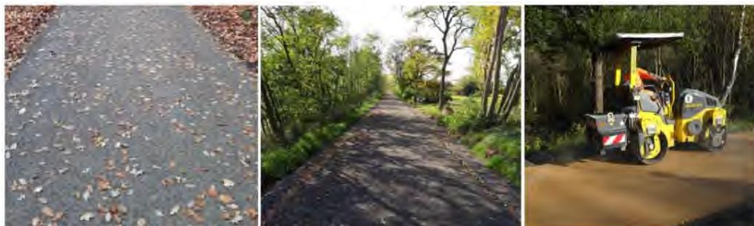
**Abbildung 4: Asphaltähnliche Deckschichten aus Gemisch von Basaltstein und Spezialsand / heller Split-Mastix-Asphalt**
