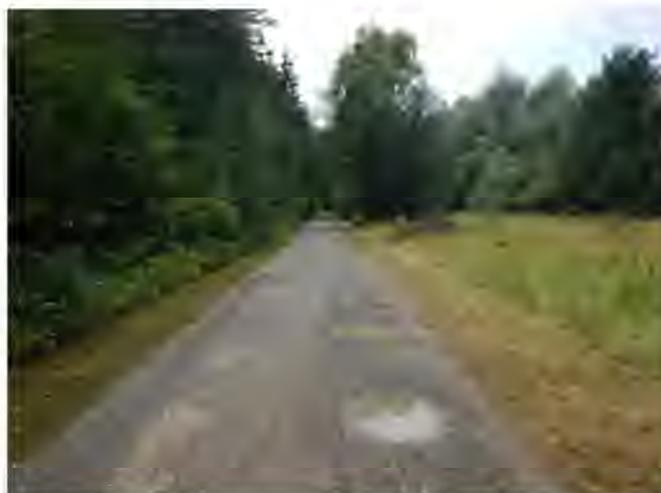
Abbildung 1, Negativbeispiel: Verdichteter Wassergebundene Decke mit Pfützenbildung und schlechter Wasserdurchlässigkeit
