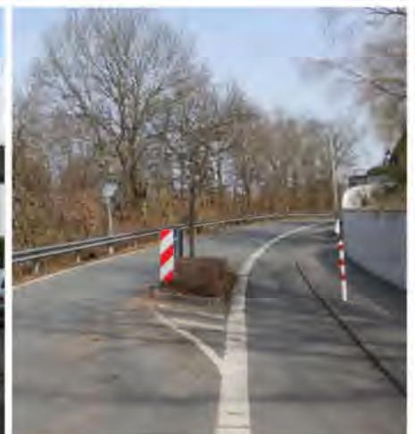
Beispiel 3: Einengung mit geradliniger Führung Radverkehr
