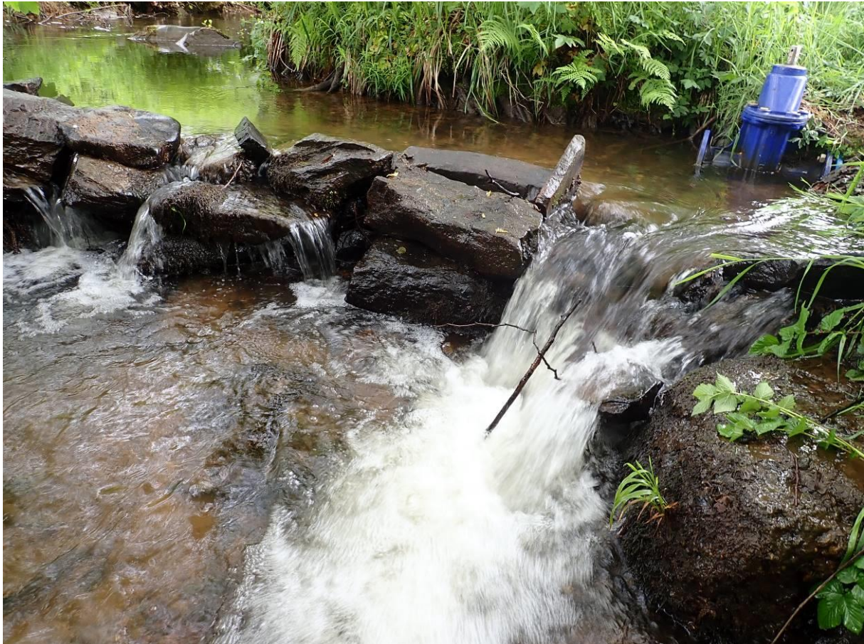
Abbildung 13: Wanderhindernis direkt unterhalb der Straßenbrücke mit Wasserausleitung
