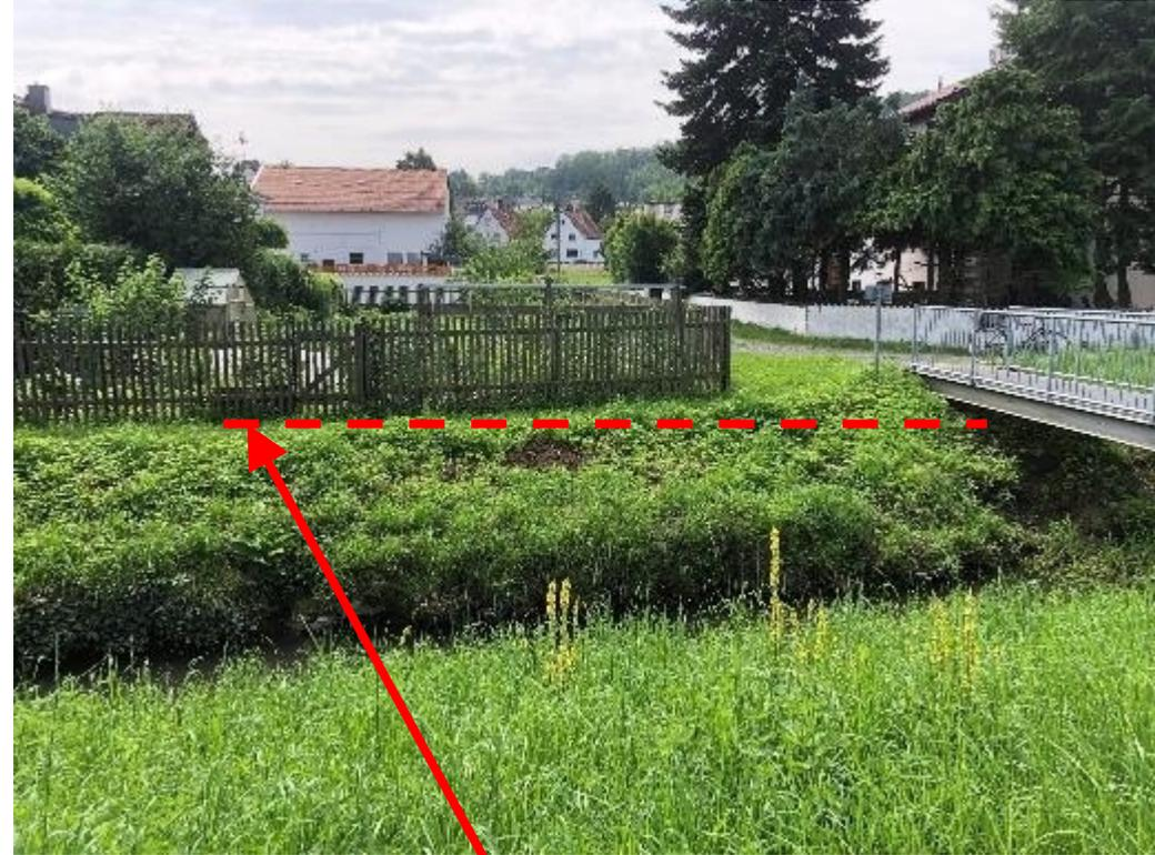
Allerdings liegt das Ufer oberhalb der Brücke niedriger als die Unterkante der Brücke. Wasser tritt dort über die Ufer schon bevor die tiefe Brücke zur Engstelle wird, würde aber eventuell zunächst noch keine großen Schäden verursachen.
