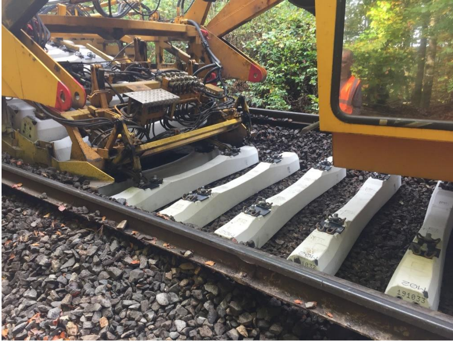
Neuverlegen von Betonschwellen mit Großumbauzug
