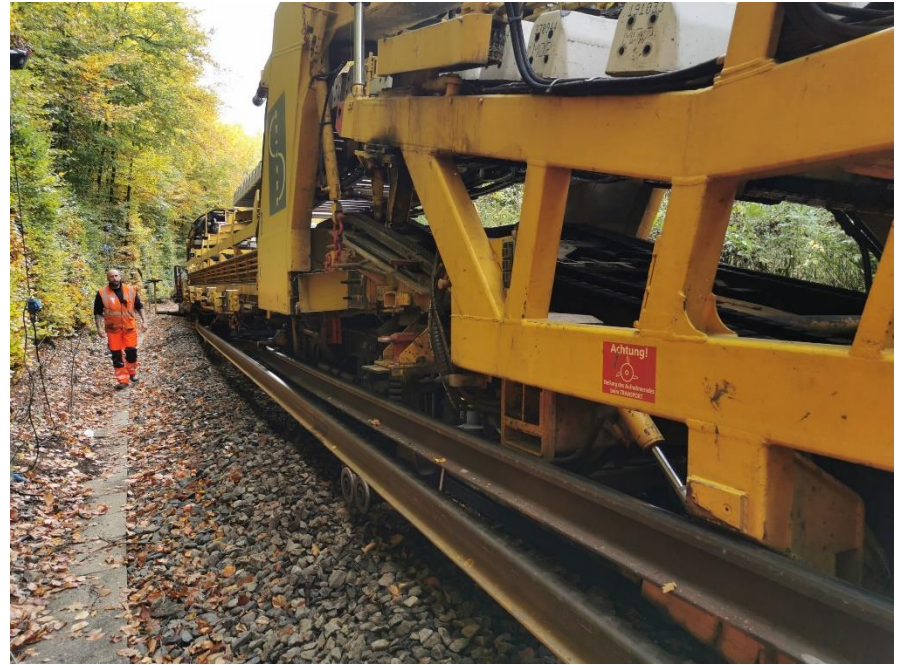
Einpassen der neuen Schienen
