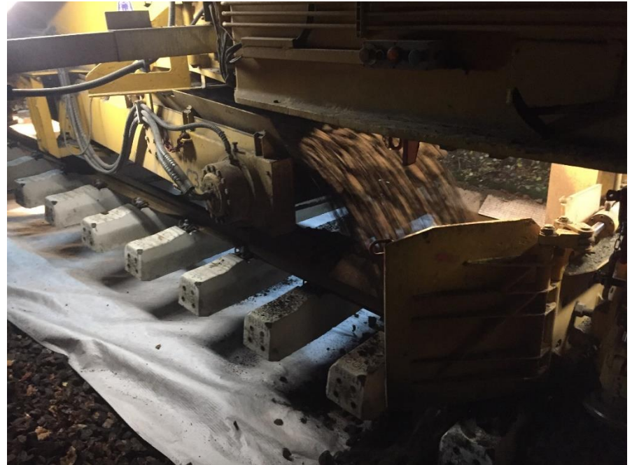
Aufbringen eines Vlieses und Wiederherstellung des Bahnkörpers mit gereinigtem Schotter
