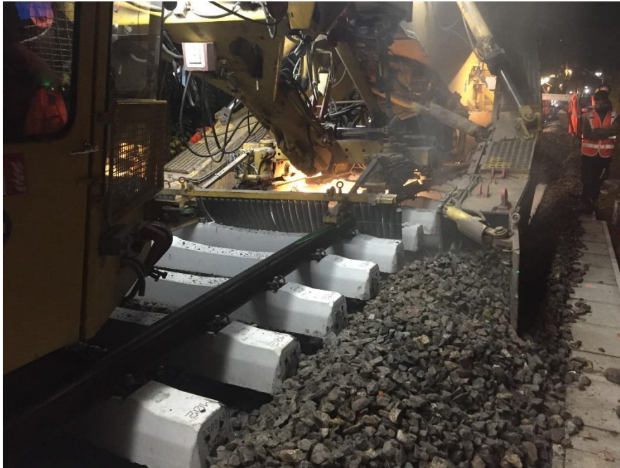
Schotteraustausch und -reinigung mit Bettungsreinigungsmaschine
