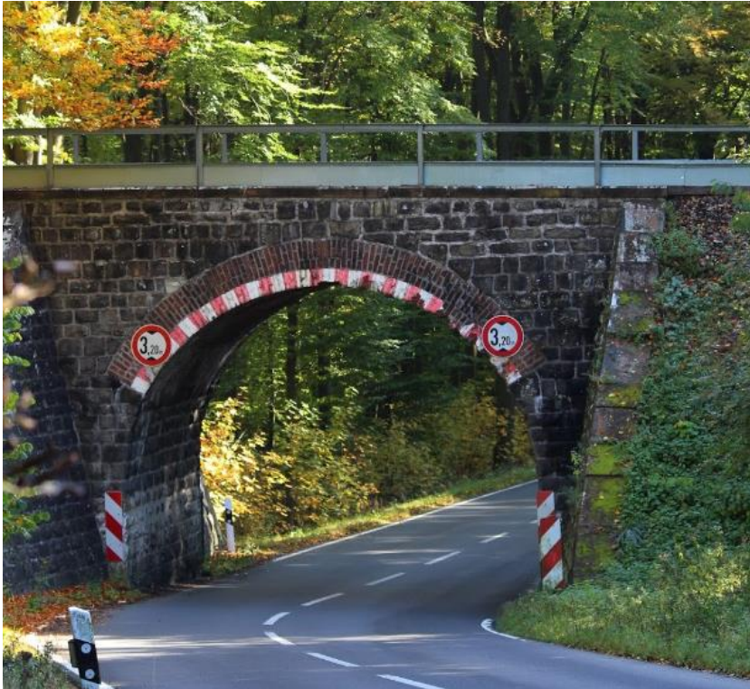
Eisenbahnüberführung über K739 bei Wilhelmsdorf, Gewölbe-/Bogenbrücke, Baujahr: 1908
