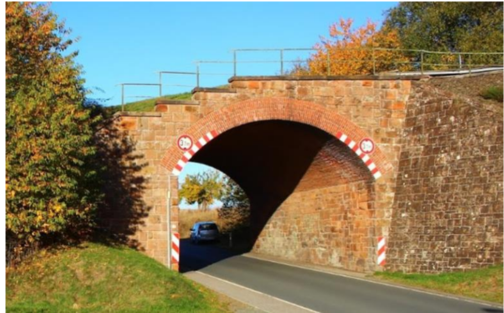
Eisenbahnüberführung über L3457 bei Naunstadt, Gewölbe-/Bogenbrücke, Baujahr: 1908
