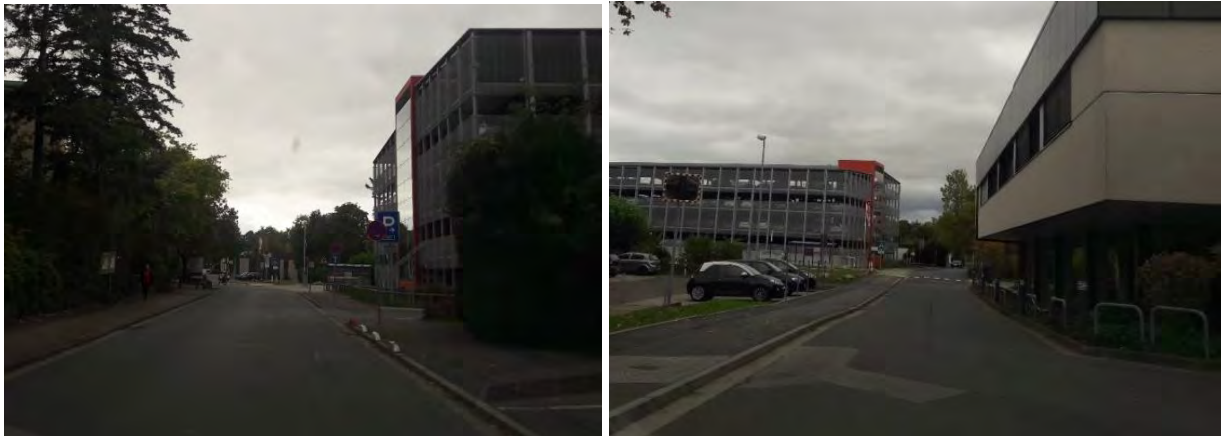
Abbildung 2.3: Fotodokumentation – innere Erschließung
