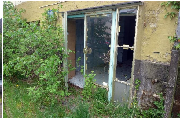
Abb. 22: Ansicht auf das Nebengebäude
