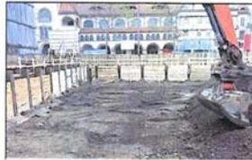
Abb. 4. Schichtenweiser Abtrag, verpflichtend bei baubegleitender KMR
