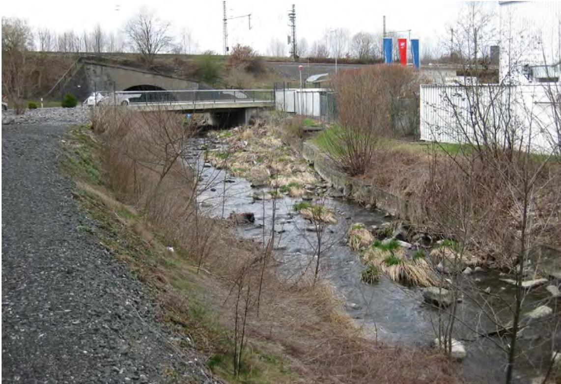
**Abb. 10:** Böschung mit Stützmauer und geschotterte Feuerwehrumfahrung
