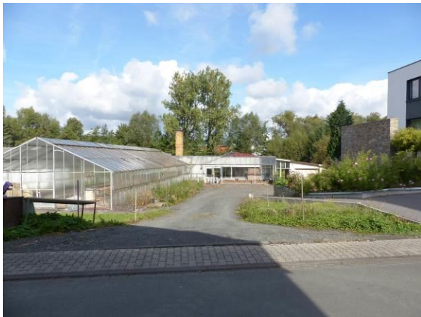
Foto 3: Blick von der Bitzenstraße auf den südl. Bereich des Plangebietes, Sept. 2015, eigene Aufnahme
