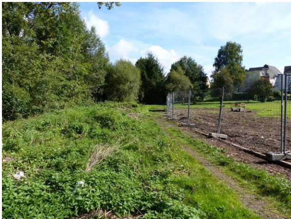
Foto 8: Uferstreifen des Aubaches Blickrichtung Osten, Sept. 2015, eigene Aufnahme
