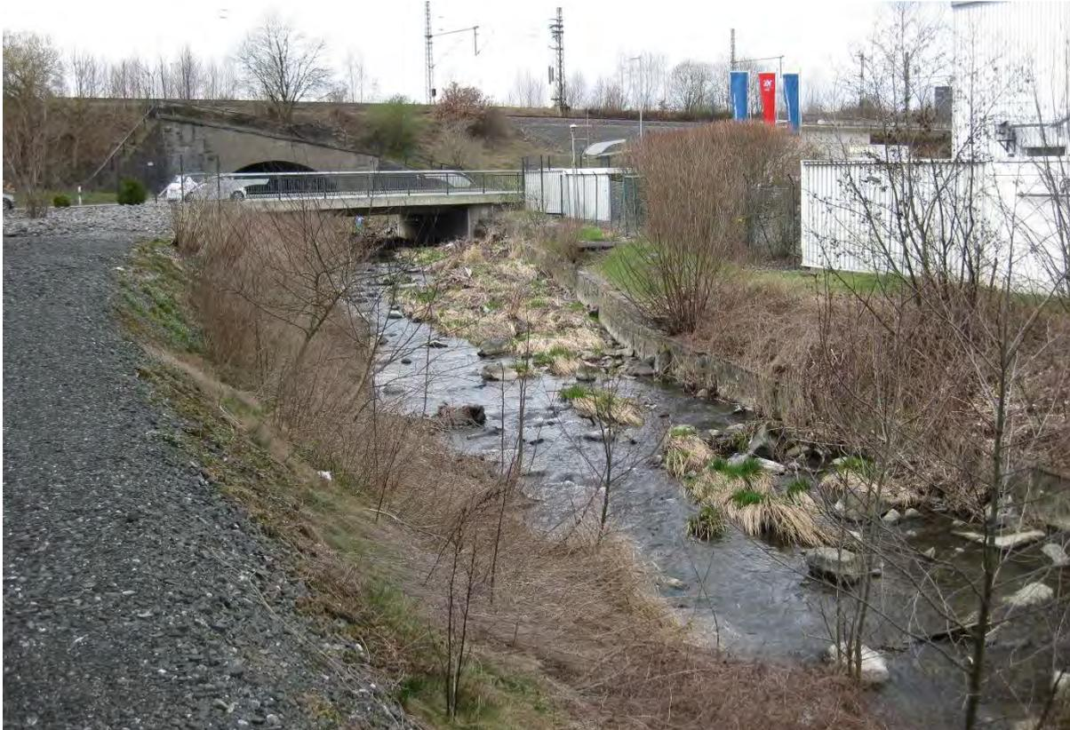
**Abb. 23:** Böschung mit Stützmauer und geschotterte Feuerwehrumfahrung
