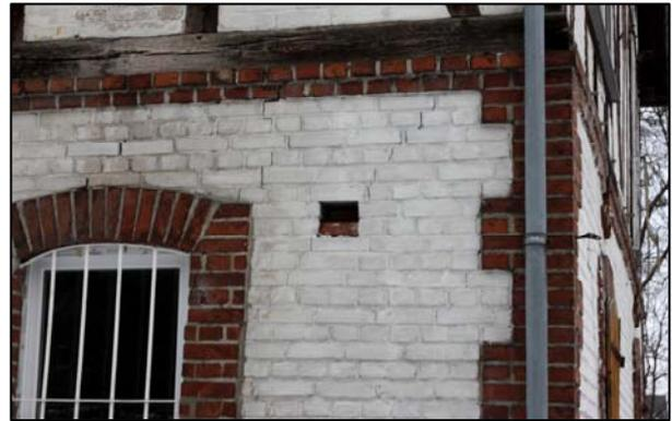
**Foto 8:** Fehlender Ziegel in der Hausfassade des östlichsten Teils des Gebäudekomplexes (eigene Aufnahme)
