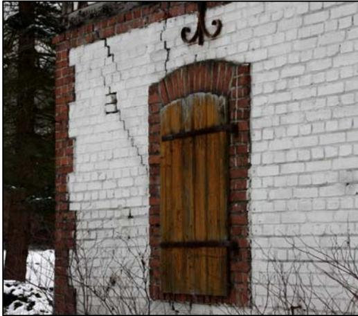
**Foto 7:** Risse in der Hausfassade und Fensterladen des östlichsten Teils des Gebäudekomplexes (eigene Aufnahme)
