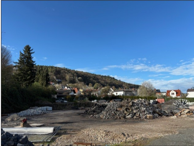
Abb. 5: Blick nach Nordost auf das ehemalige CAP-Markt-Gelände Quelle: eigene Aufnahme
