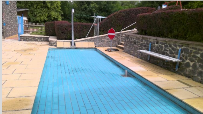
Durchschreitebecken und Zugänge nicht barrierefrei
