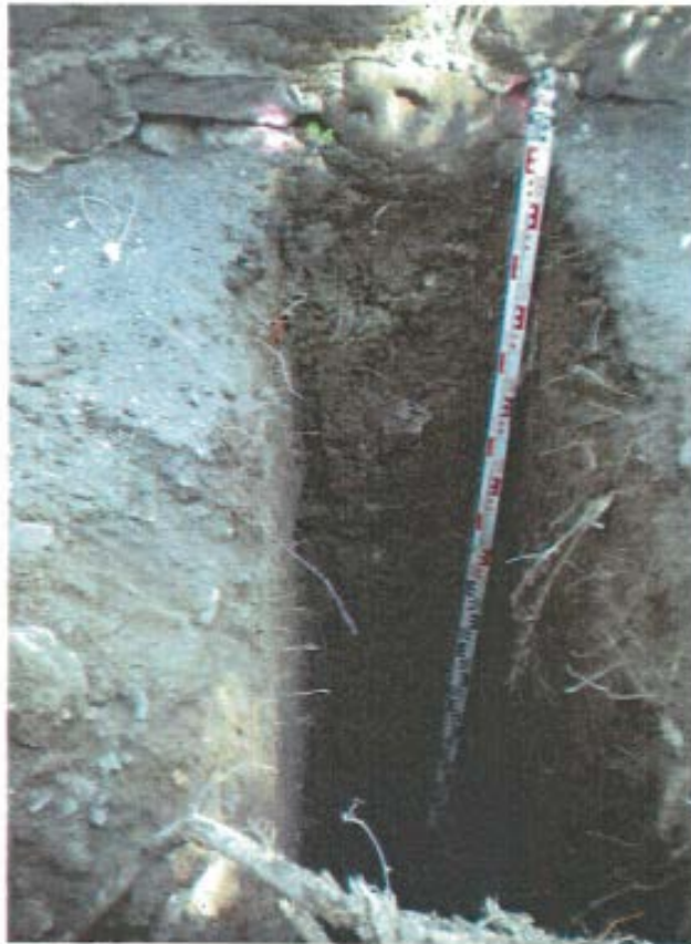
SCH 11 Rückseite historische Mauer - hinterfüllt -
