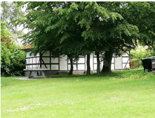
Trafostation und Gerätehaus
