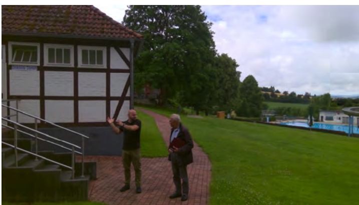
Bestandsgebäude Kasse, Umkleiden, DLRG
