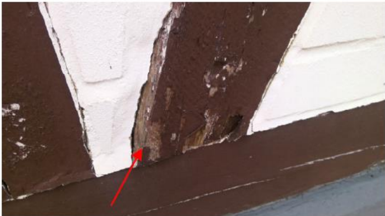
Fachwerk durchnässt und faul, Oberflächen wurden versiegelt
