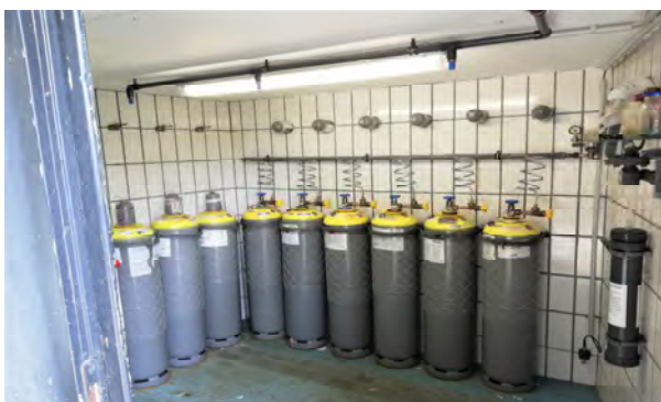
Chlorgasanlage
