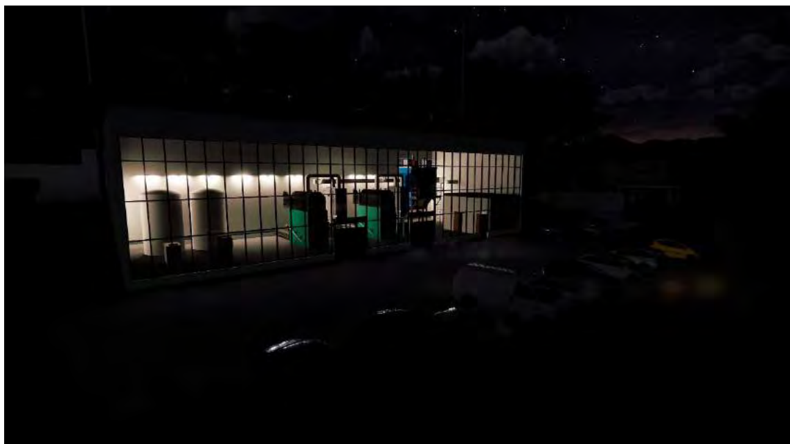
Abbildung 48: Ansicht der Heizzentrale in den Nachtstunden
