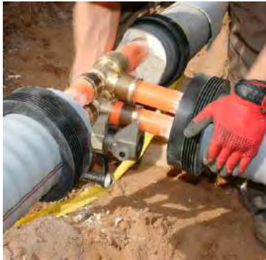
Abbildung 42: Einbausituation für die Nahwärmeleitungen
