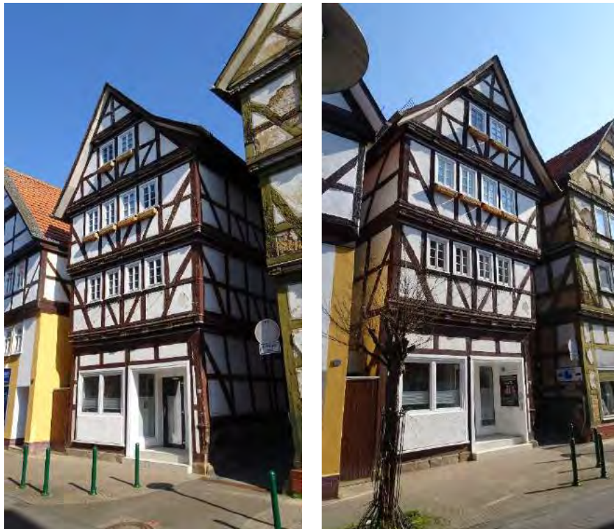
Abbildung 20: Typisches kleineres Fachwerkhaus in der Untergasse
