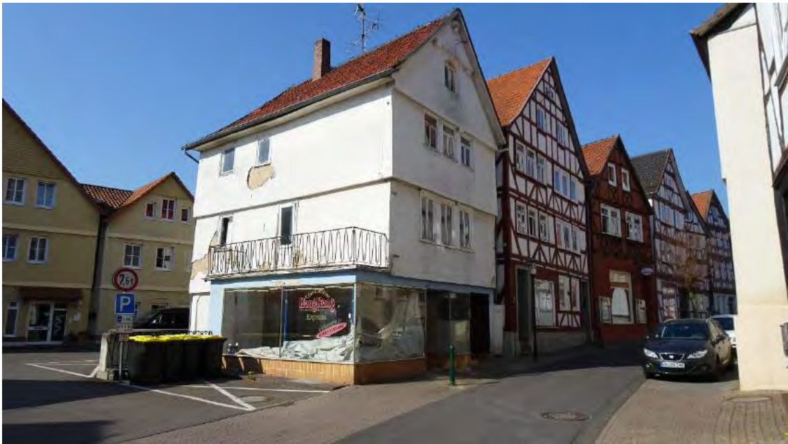
Abbildung 21: Wohngebäude und Laden in der Untergasse mit erheblichen Sanierungsstau
