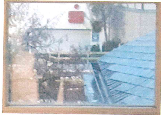
Blick aus dem Treppenhaus THS: Freifläche führt auf das Garagentor (Aufnahmen vom 28.01.2020)
