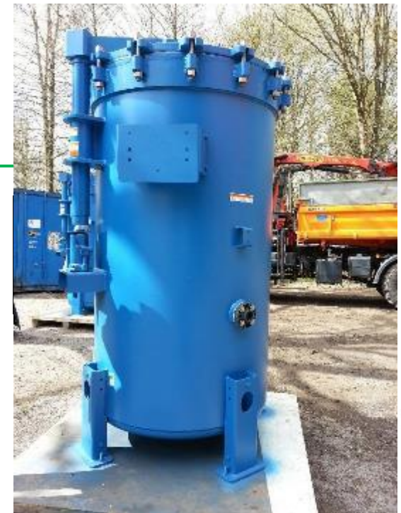
System Anschwemmfilter (Defender) Sportbecken im Freibad
