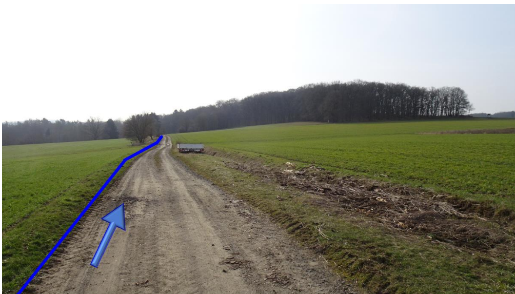
Abbildung 11: Druckleitung Dickershausen – Übergabepunkt – Foto 2 der Trasse
