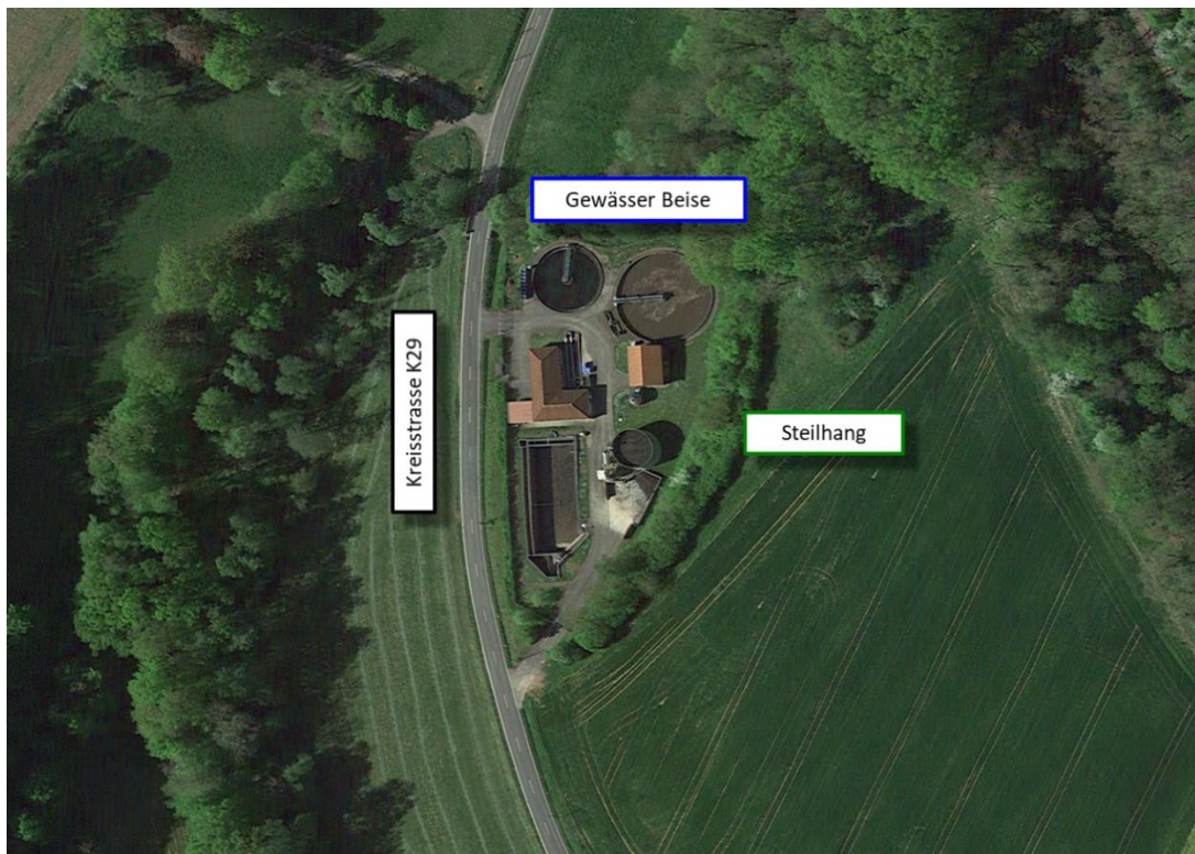
Abbildung 7: Kläranlage Niederbeisheim – Luftbild
